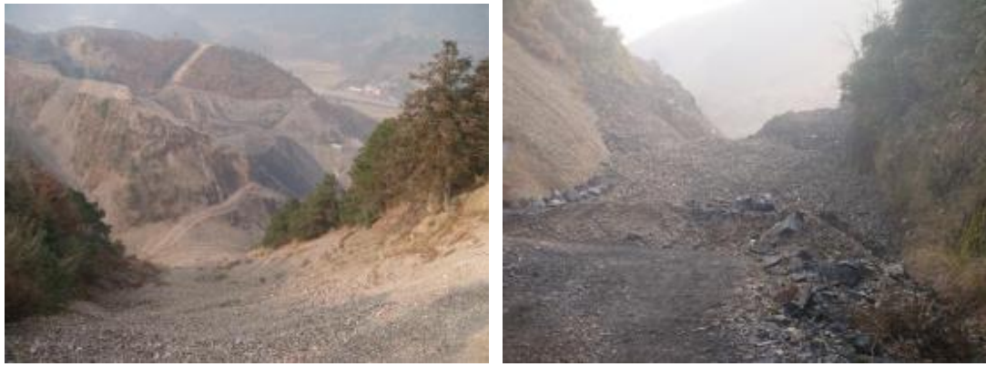
图 3.2-8 项目区治理工程前泥石流状况
