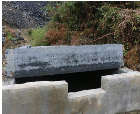
图 3.2-5 张家湾钒矿矿区重金属污染综合治理（一期）污水收集池
