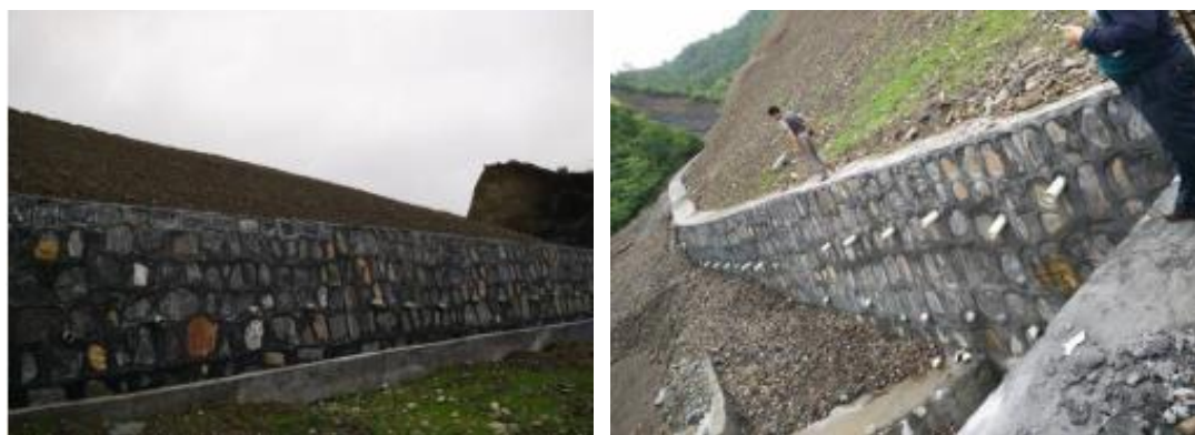
图 3.2-10 项目区治理工程实施后-砌筑挡渣墙
