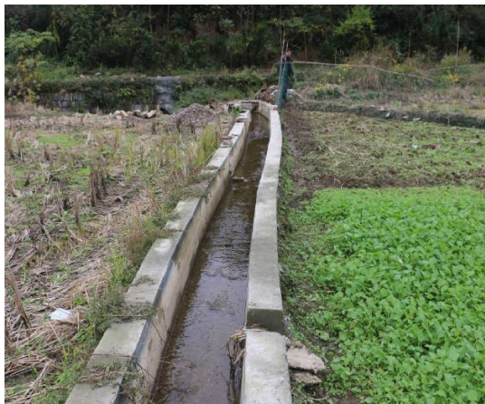
图 3.2-4 张家湾钒矿矿区重金属污染综合治理（一期）清污分流工程
