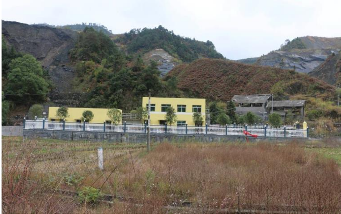
图 3.2-3 张家湾钒矿矿区重金属污染综合治理（一期）废水处理站
