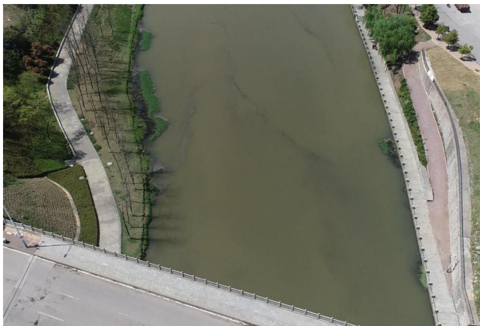
图 3.7-3 现状河道淤积图（黄花坪桥处）
