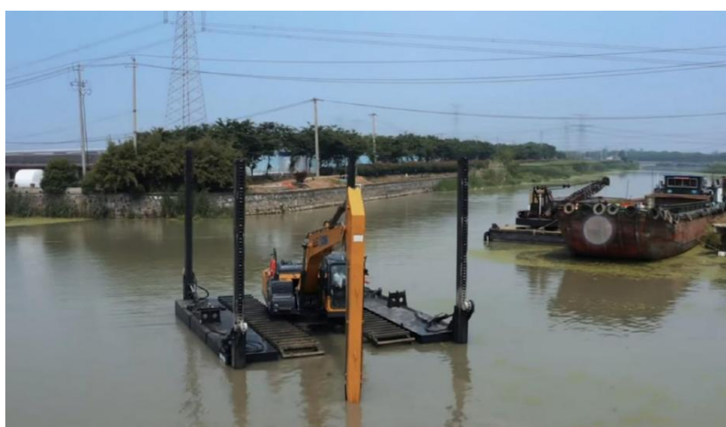
图 2.4-5 水陆两栖挖掘机+驳船
