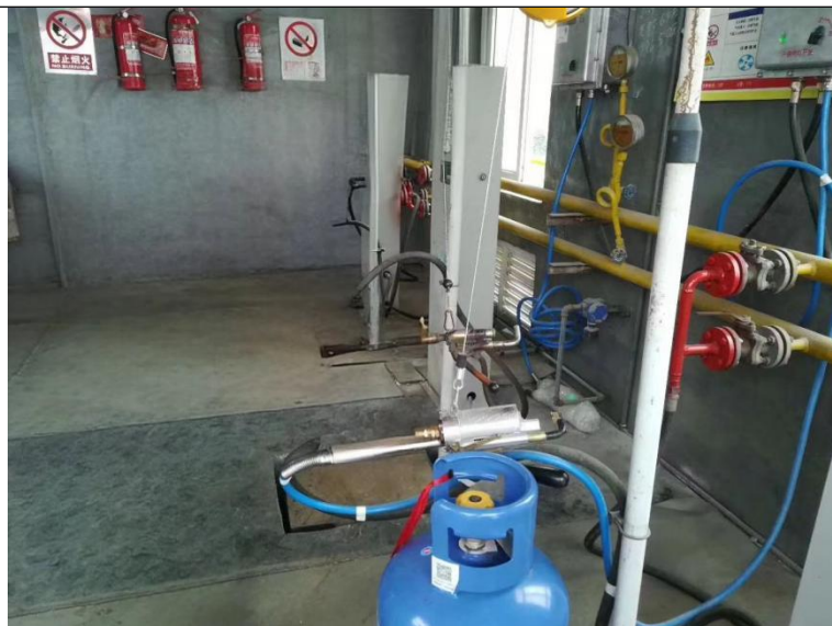
图 2-2 液化石油气分装过程示意图
