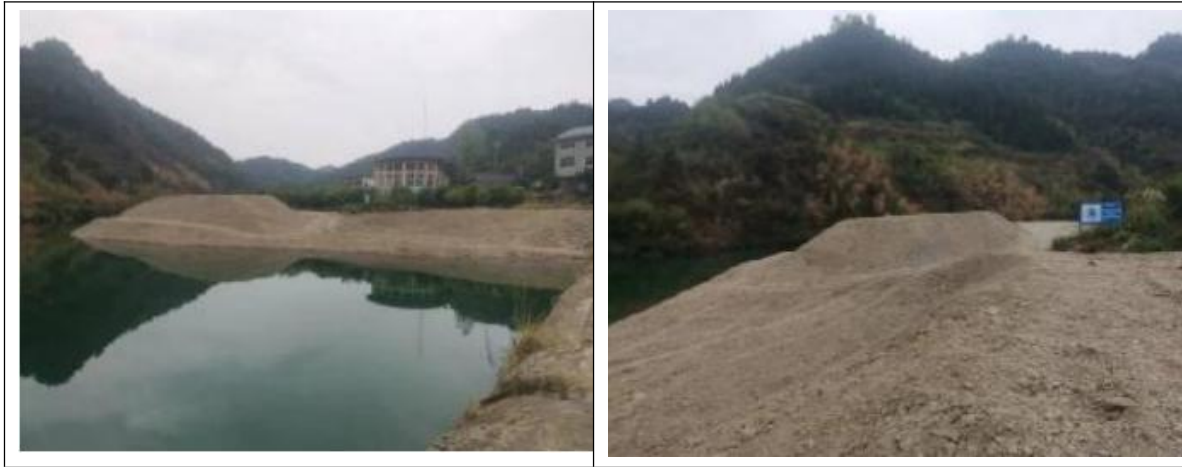
图 3.3-4 上游河道，现状左岸淤积清理堆砂
