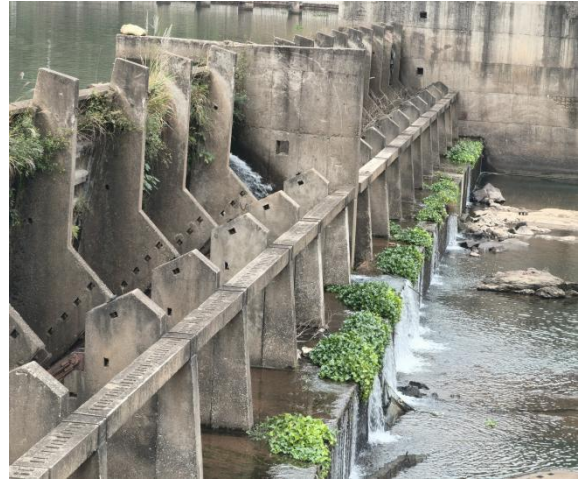
翻板闸下游巡查步道现状
