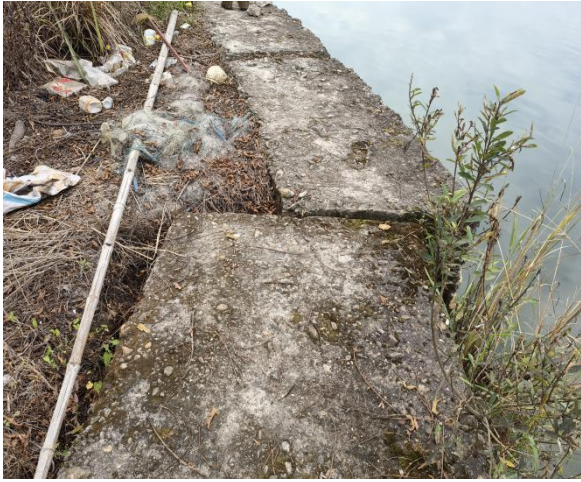
右岸上游挡墙（挡墙位移）
