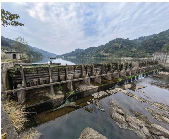
现状水力自控翻板坝
