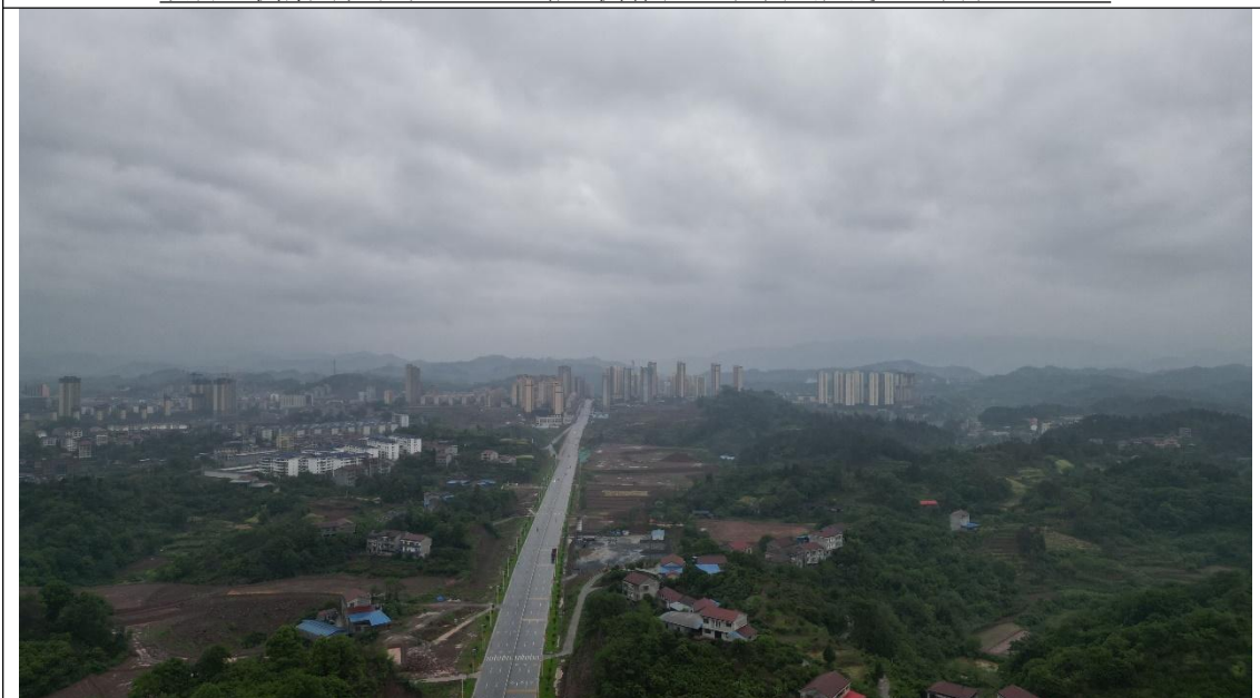
项目东侧主要以林地为主，存在十余户居民，距离县城建成区约 2.2km
