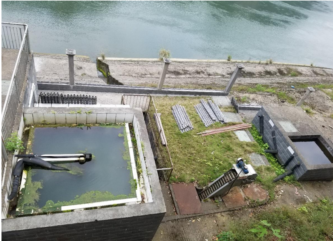
图 3.1-2 现有污水处理设施
