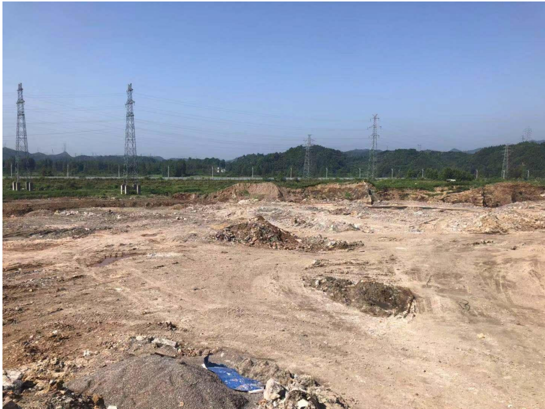
弃渣场转运情况（摄于 8 月 13 日）
