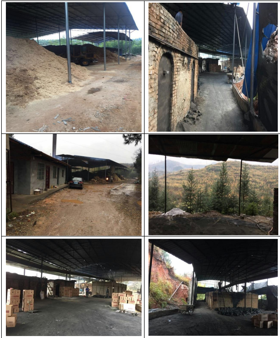
图 4 现场勘查照片
