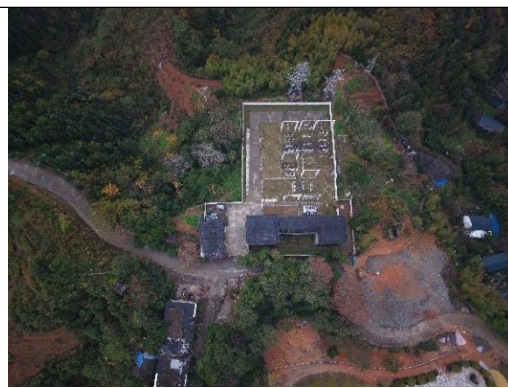
尖坡 110kV 变电站周围环境现状
