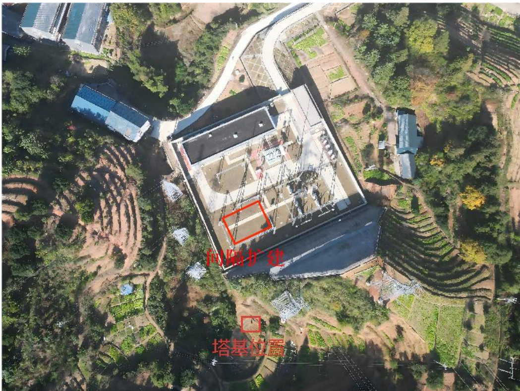
图 4.7-1 清江湖 110kV 变电站现状图
