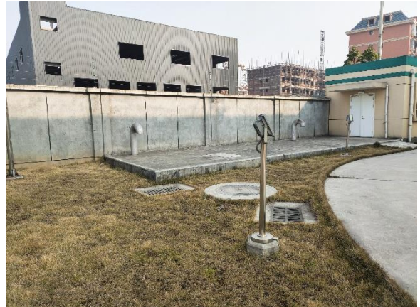
站内化粪池、雨水下井及消防水池
