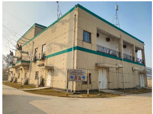
城南 110kV 变电站综合楼
