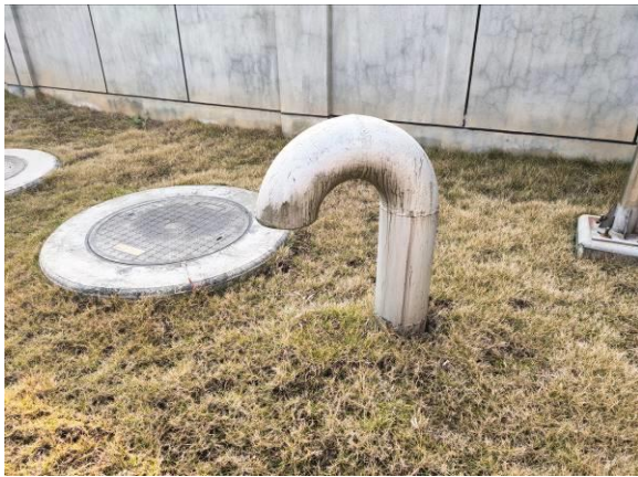
站内事故油池
