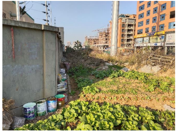
城南 110kV 变电站东侧
