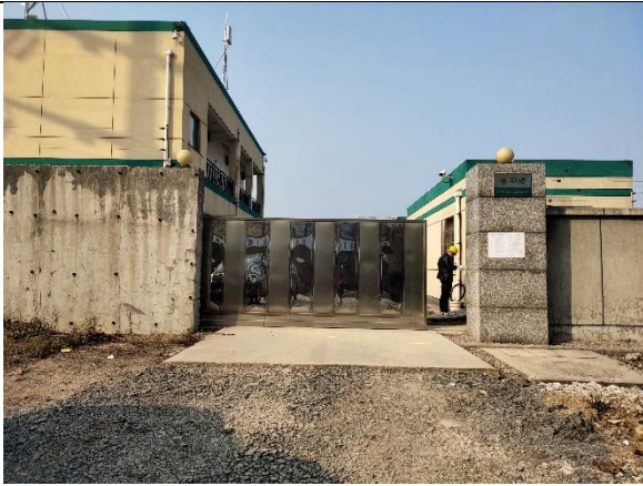
城南 110kV 变电站大门
