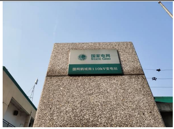
城南 110kV 变电站铭牌
