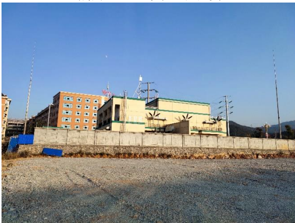
城南 110kV 变电站西侧
