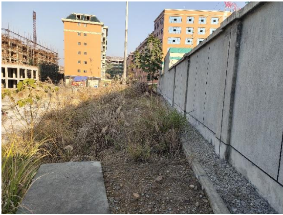
城南 110kV 变电站北侧
