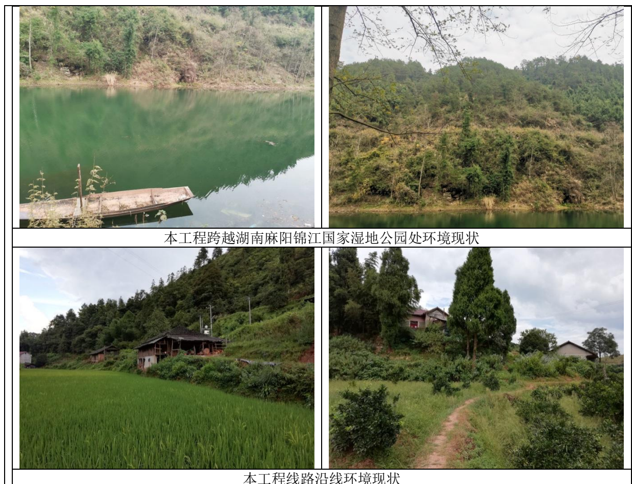
图 8 张吉怀铁路湖南怀化桐田湾牵引站 220kV 外部供电工程周边环境现状
