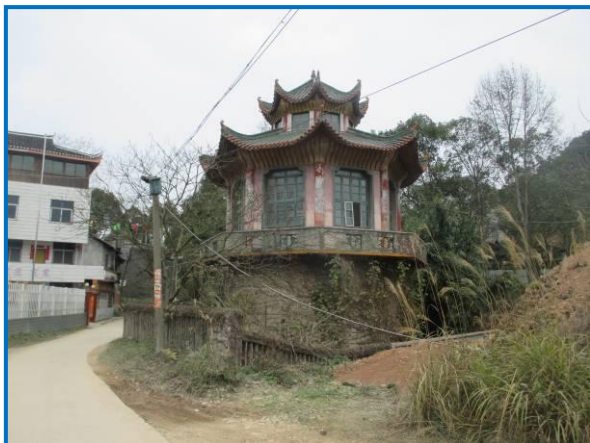
图 1.7-7 会同县自来水厂取水口
