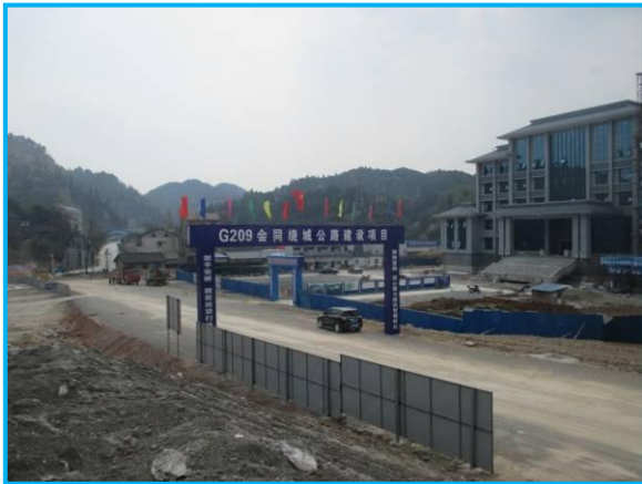
图 2.2-4 白泥堆场西南侧 G209 绕城公路
